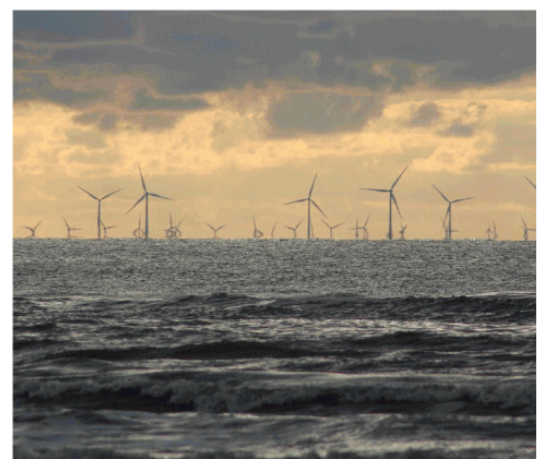
Parco eolico, si allungano i tempi
