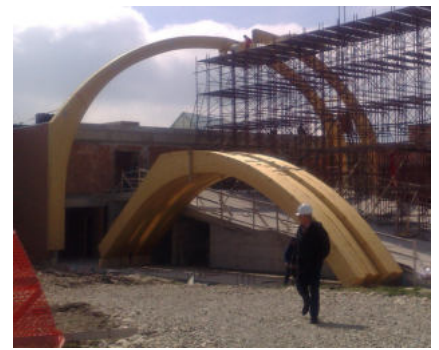
Strutture in legno lamellare
