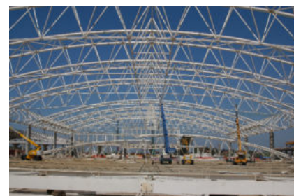
Centro servizi fiera di Milano
