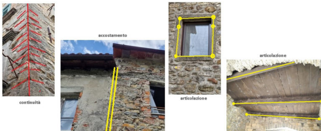
Fig. 26 - Ipotesi di attribuzione delle modalità di vincolo
