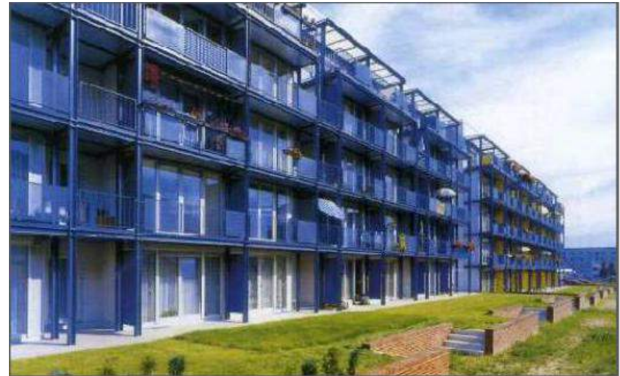
Edifici residenziali in Lessingstrasse, Leinefelde, Germania: dopo la riqualificazione
