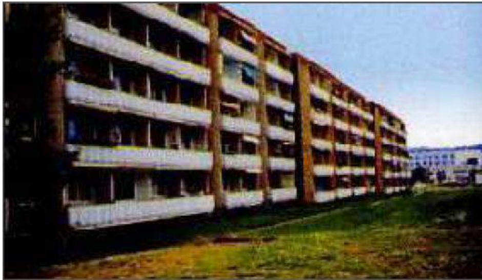
Edifici residenziali in Lessingstrasse, Leinefelde, Germania: prima della riqualificazione
